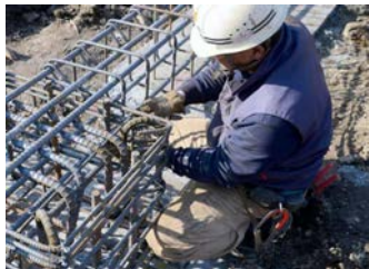
鉄筋の組み立て
