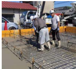
コンクリート打設
