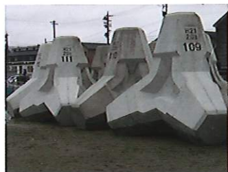
波消ブロック
