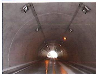
トンネル覆工
