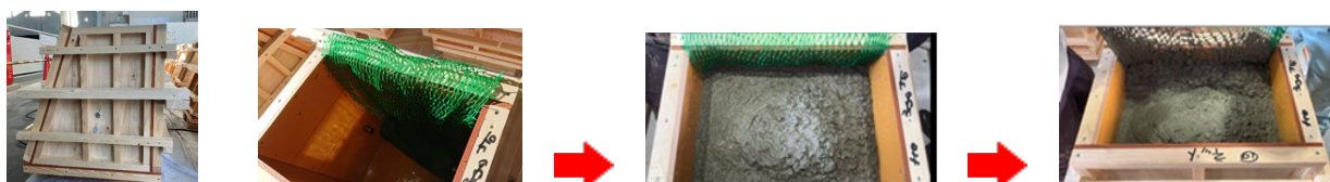
図-3 園芸ネットを使用した場合の打設
