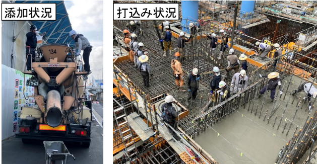
写真-2 施工状況
