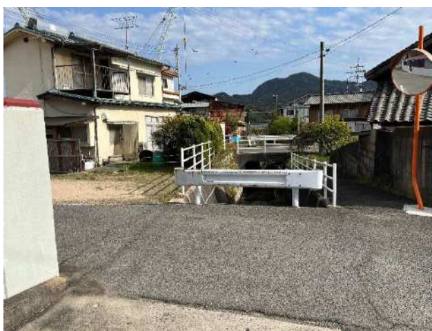
写真-1 対象構造物（全景）
