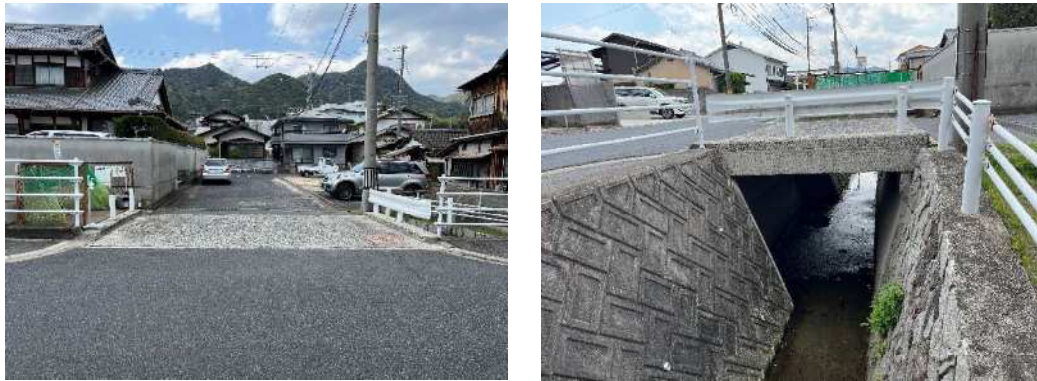
写真-1 対象構造物（全景）
