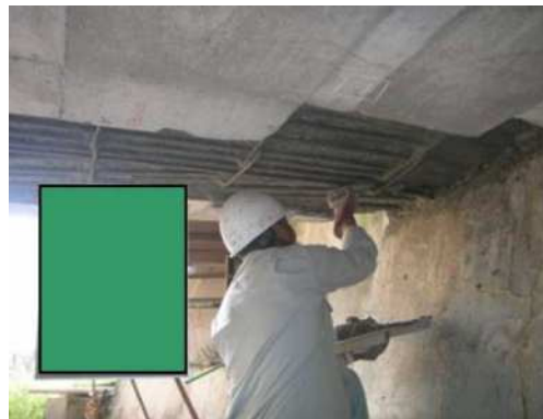
写真-5.1 断面修復工の実施状況
