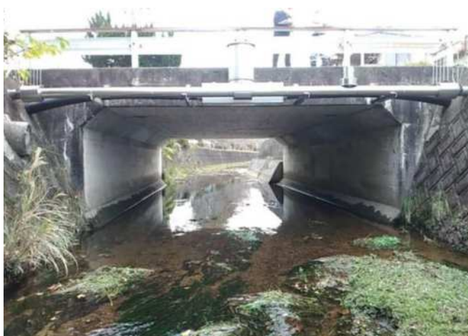
写真-1 対象構造物（全景）
