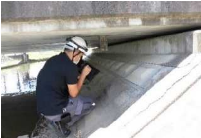
写真-1 タブレット活用した橋梁点検の様子
