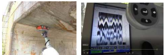
電磁波レーダー法 かぶり厚さ結果 写真-2 配筋状況、かぶり厚さ測定状況
