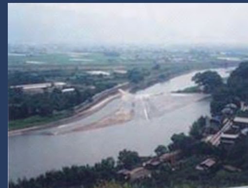
筑後川 山田堰(福岡県 朝倉)
