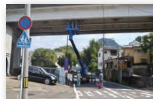
高所作業車を用いた桁下の近接目視点検
