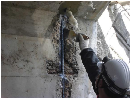
亜硝酸リチウム含有ペースト塗布 ※鉄筋腐食抑制(防錆)
