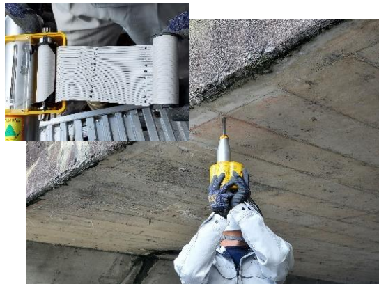
コンクリート強度の測定
