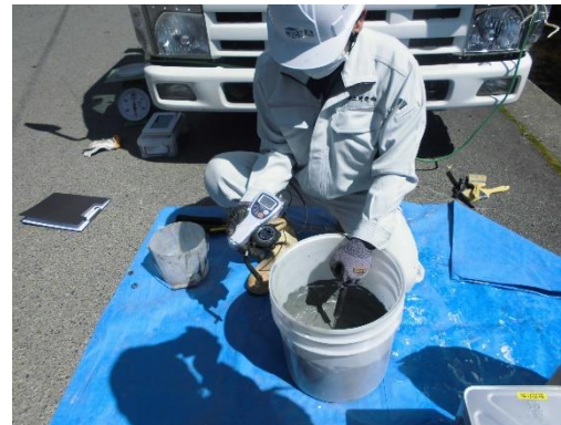
シール材の確認
