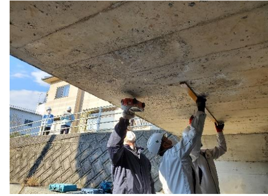
配筋位置の確認状況
