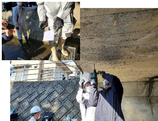
中性化深さの測定
