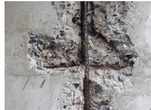
鉄筋の状況確認(2日後の状況)
