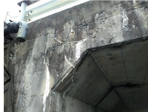
水分計による水分量の確認(4.5%) 補修前の状況
