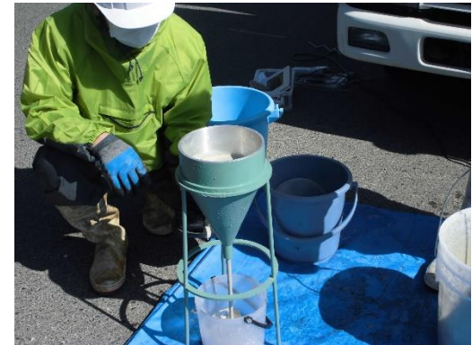
注入材の確認(エポキシ樹脂系) ※ひび割れ硬化
