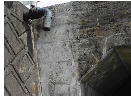
補修後の状況
