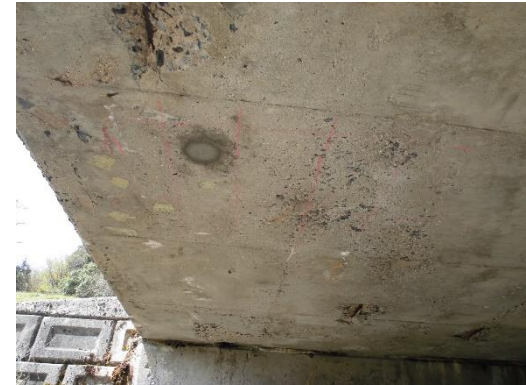
コア抜き取り後の処理
