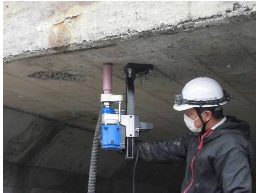
塩化物イオン測定用コア抜き取り
