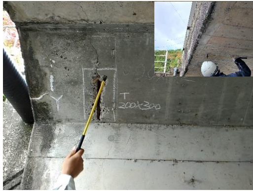
打音検査の状況
