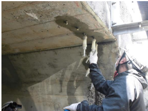
注入器具の取付
