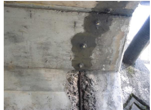
シール材の施工
