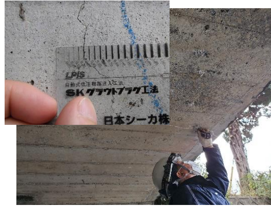
ひび割れの大きさ確認・記入
