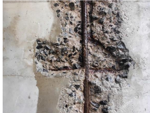
亜硝酸リチウム含有塗料塗布 ※不動態被膜を再生
