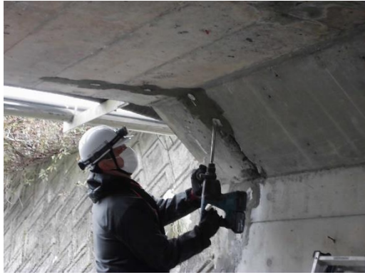
注入台座の取り外し
