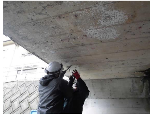
コンクリートの浮き部の撤去
