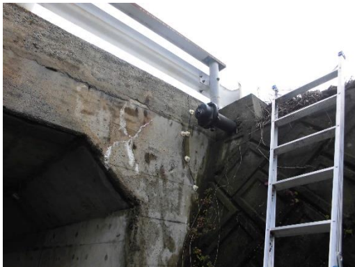
注入台座取付
