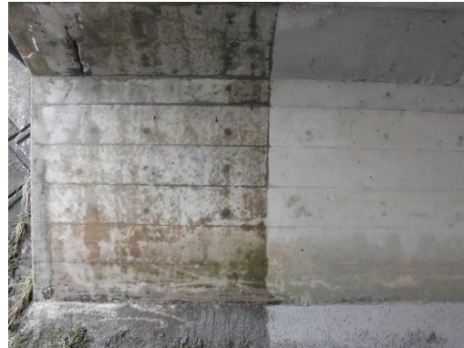
塗布後の状況(両側, 橋梁端部から2m程度塗布)
