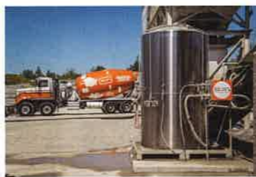
写真-1 カーボンキュアコンクリートの製造
