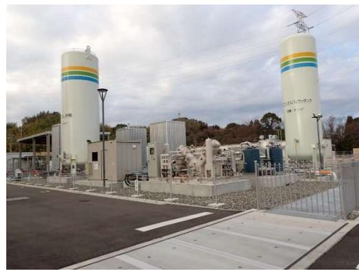
「Gas-to-Lipids バイオプロセスの開発」では，バクテリアに CO<sub>2</sub> と H<sub>2</sub> を与えて酢酸を生成し，その酢酸を微生物に与えて脂質を製造するという二段階発酵のプロセスの最適化について研究が行われていた。1L の培養液から1日 30g の油脂を製造できるそうで，配管がむき出しの複雑な製造装置の外観に圧倒された。
