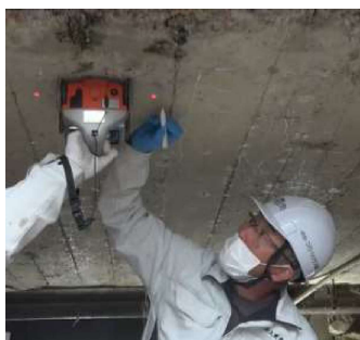
橋梁点検・詳細調査
