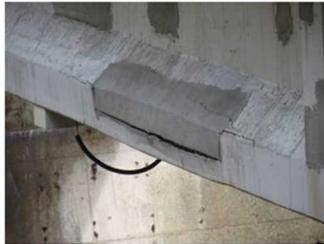
解図 2.5 マクロセル腐食により再劣化した断面修復部の例
