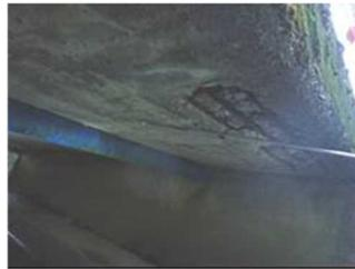
解図 2.2 初期不具合により上部工コンクリートが剥落した短支間橋梁
