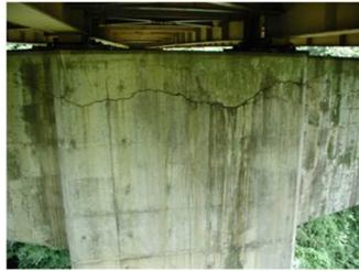
解図 2.4 ASR により劣化した橋梁の例
