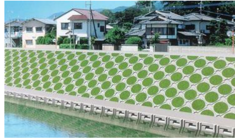
法面保護ブロック
