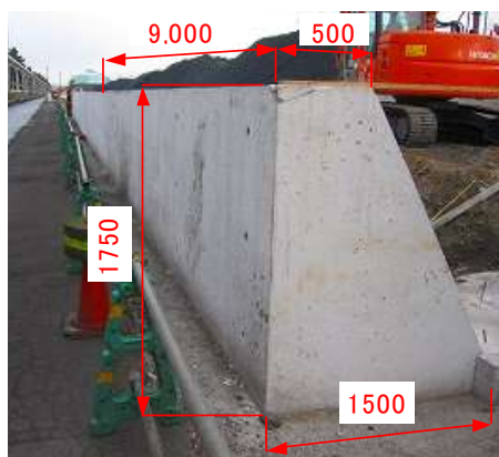
写真-1. 重力式擁壁
