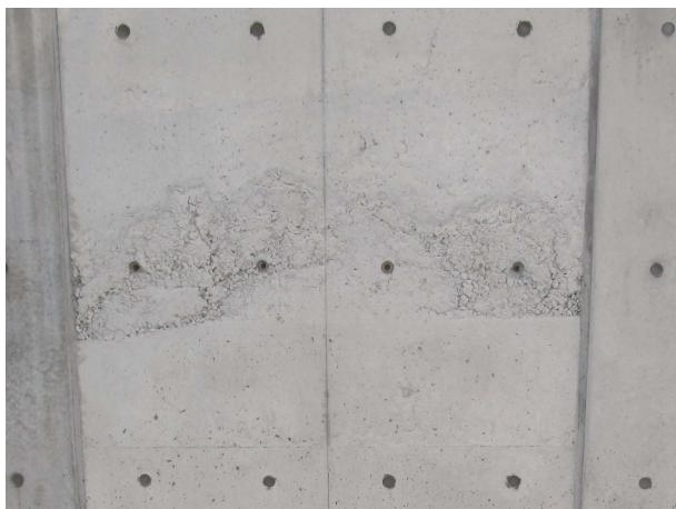
※充填不良によるジャンカは施工上の不備だけでなく、材料の不備によっても発生する可能性がある。
