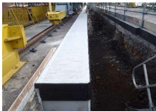
写真-6 脱枠後の出来栄
