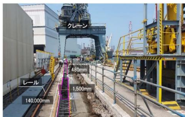
写真-1 現場状況
