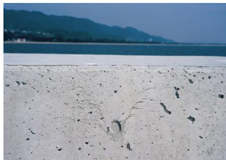
写真-1 型枠面に生じる沈下ひび割れ
