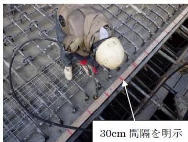
図-11 小径パイプレーターによる締固め
