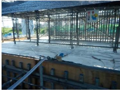
図-10 湛水養生状況
