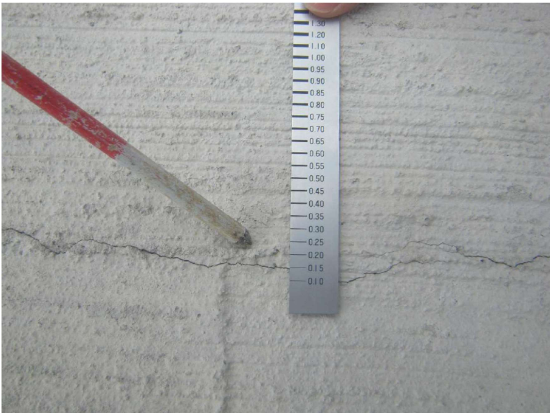
右岸 No.1 ひび割れ幅 0.15mm
