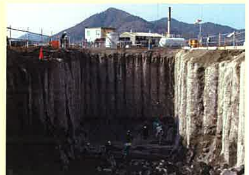
FCスラリーによる施工状況 (ブロック改良部)
