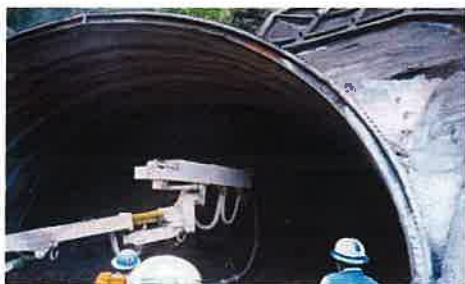
EPショット(トンネル吹付)
