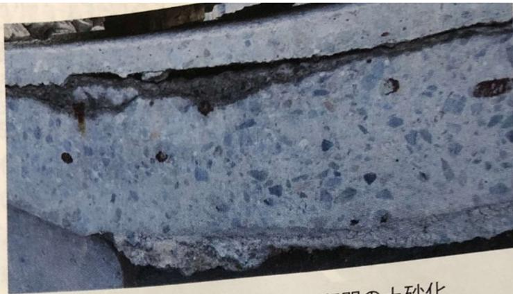
写真-3 増厚層と既設 RC 床版間の土砂化
