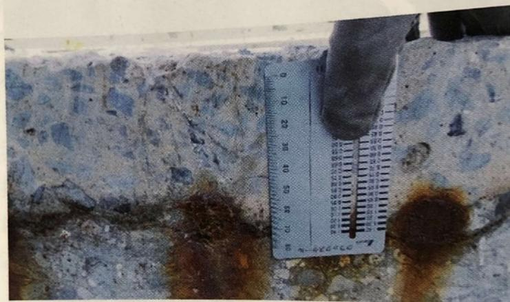
写真-4 上段鉄筋位置で打替えた床版 (劣化)
