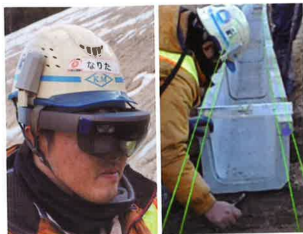
実際の現場風景に側溝の設計位置が重なって見える。 (資料) 筆者撮影
