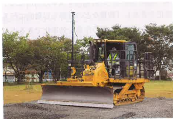
3Dマシンコントロールによって、3Dデータ通りに地盤を造成する。 (資料) 筆者撮影
