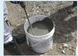
基本配合は、グラウト1kgに対し水150gです。容器に水を入れた後、グラウト材を混入し3分間攪拌します。その後、1~2分程度放置した後使用します。
