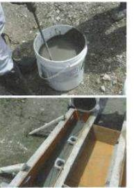
写真2 ■ パワーグラウトの施工。上は配合の様子。罫線に木を入れた後、グラウト材を注入して分厚くはさん。その後、1〜2分程度置き、下は施工中。流動性が高いため狭い場所でも使用できる
