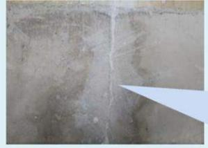
ひび割れが発生した場合、雨水等により水分が供給されることで、グラウト内部の自己治癒成分が反応し、ひび割れを閉塞(自己治癒)させます。
