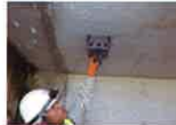
鉄筋探査(電磁波レーダ法)
