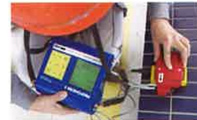
二次製品の出来形検査(鉄筋探査)
