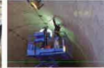
トンネル点検
