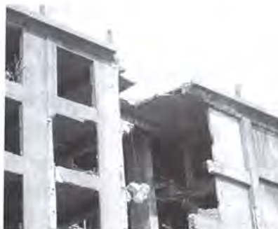
写真2 30号棟南面外壁の状況
