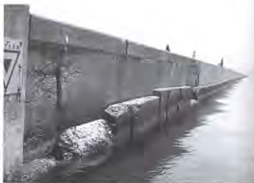
写真 1908年竣工の小樽港北防波堤 1)
