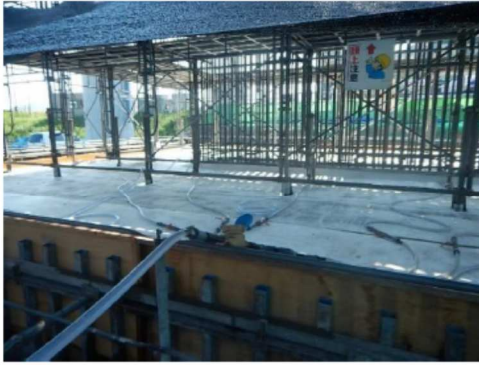
図-10 湛水養生状況
