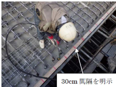
図-11 小径バイブレーターによる締固め
