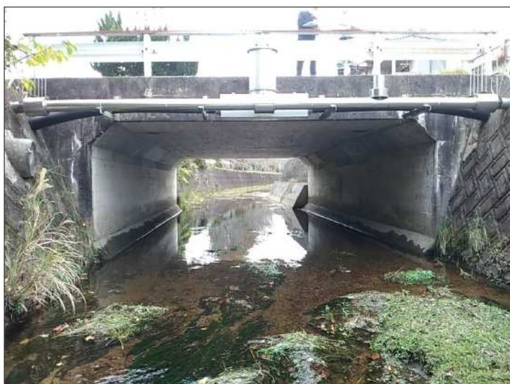
点検実施状況写真 場所:工業団地橋 点検日:2020年11月10日
