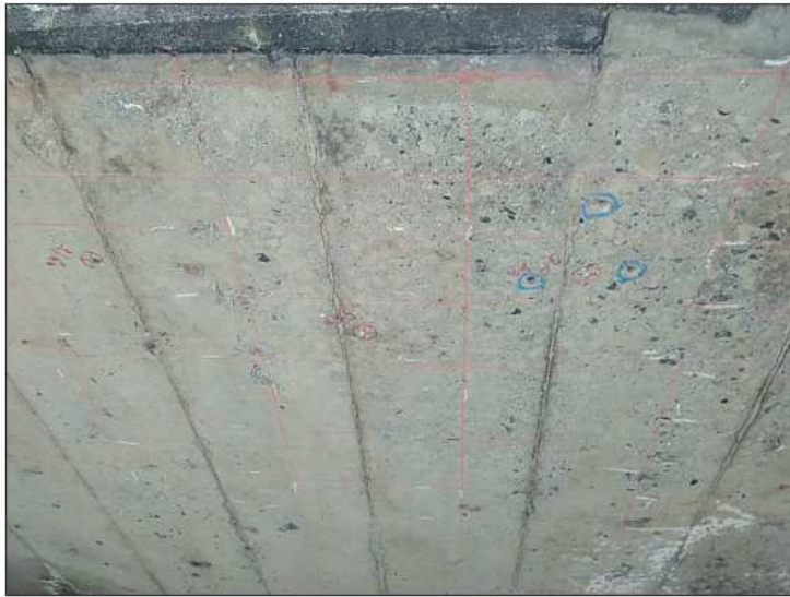
点検実施状況写真 場所:工業団地橋 点検日:2020年11月10日 ・上流側1m程度の床版面 (調査実施箇所)
