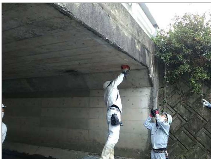
点検実施状況写真 場所:工業団地橋 点検日:2020年11月10日 ・鉄筋探査状況
