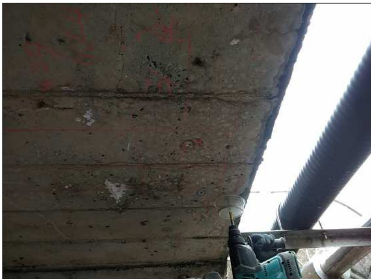
点検実施状況写真 場所:工業団地橋 点検日:2020年11月10日 ・塩化物イオン量の測定 (ドリル粉末採取状況)
