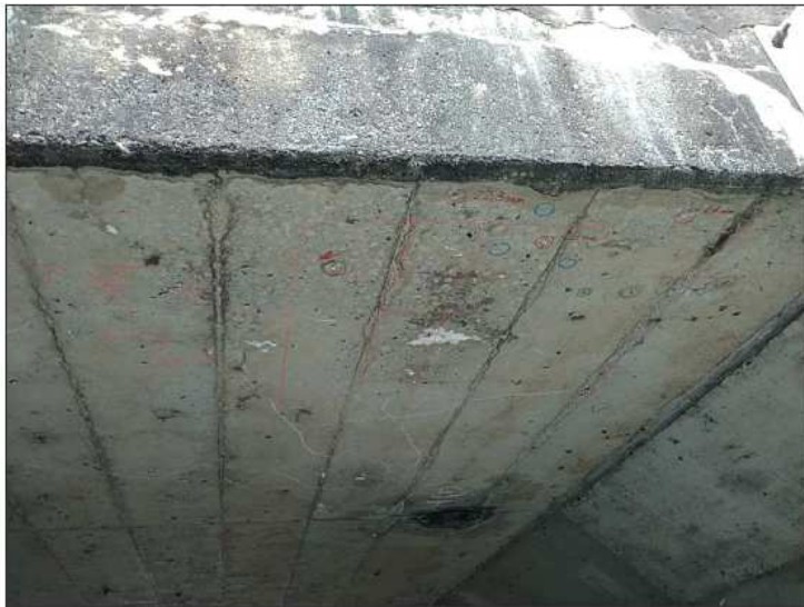
点検実施状況写真 場所:工業団地橋 点検日:2020年11月10日 ・下流側1m程度の床版面 (調査実施箇所)
