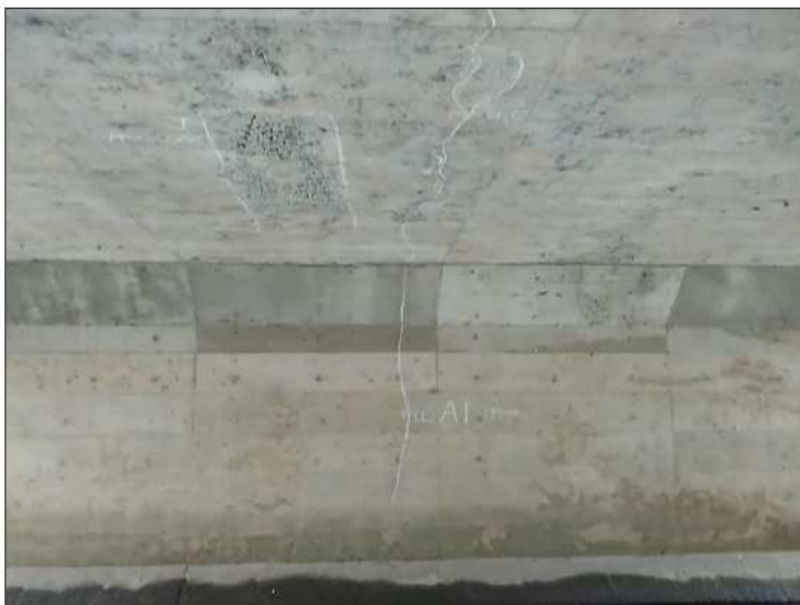
点検実施状況写真 場所:工業団地橋 点検日:2020年11月10日 ・外観検査 (マーキング状況)
