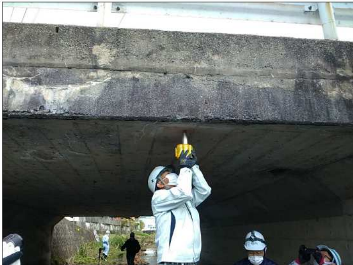
点検実施状況写真 場所:工業団地橋 点検日:2020年11月10日 ・強度確認 (シュミットハンマー使用状況)
