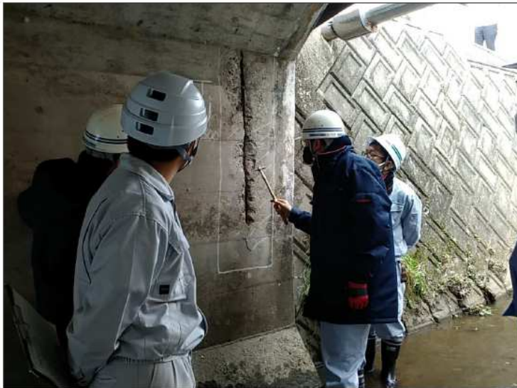
点検実施状況写真 場所:工業団地橋 点検日:2020年11月10日 ・外観検査 (打音調査状況)
